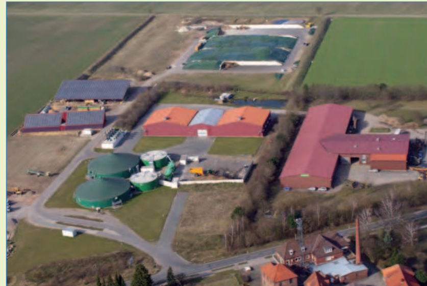
Biogasanlage innerhalb eines Gewerbegebietes am Ortsrand
